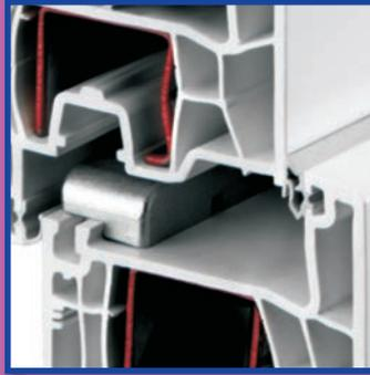
Spezielle Anlagepunkte halten die Stahlverstärkung in der richtigen Position.
